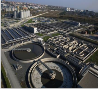
Ambarlı Atık Su Tesis
