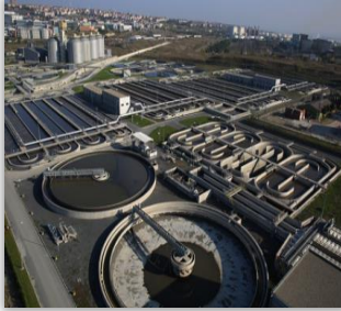
Ambarlı Atık Su Tesis
