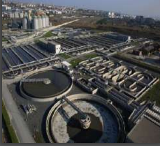
Ambarlı Atık Su Tesisi
