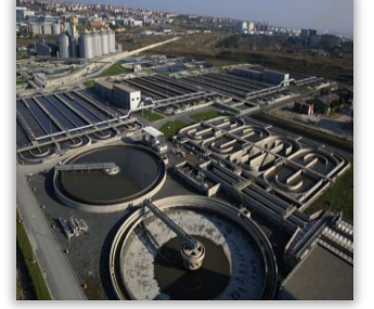
Ambarlı Atık Su Tesisi
