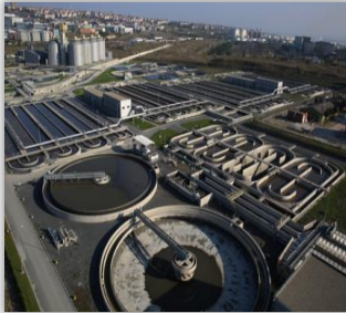
Ambarlı Atık Su Tesis
