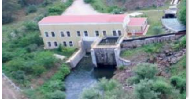
ÇAYGÖREN HPP 4.60 MW
